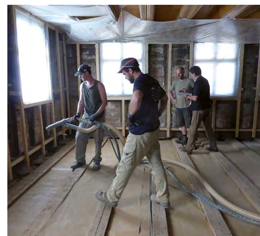
Projection du béton de chanvre après protection des fenêtres et passage des gaines techniques et des canalisations.
